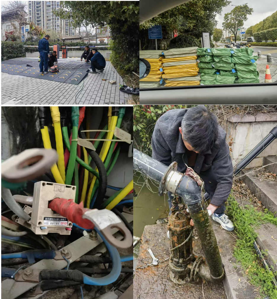
（开展善园日常维修）
